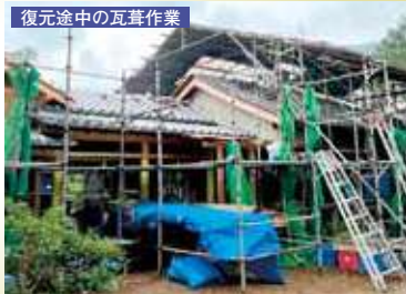
復元途中の瓦葺作業
